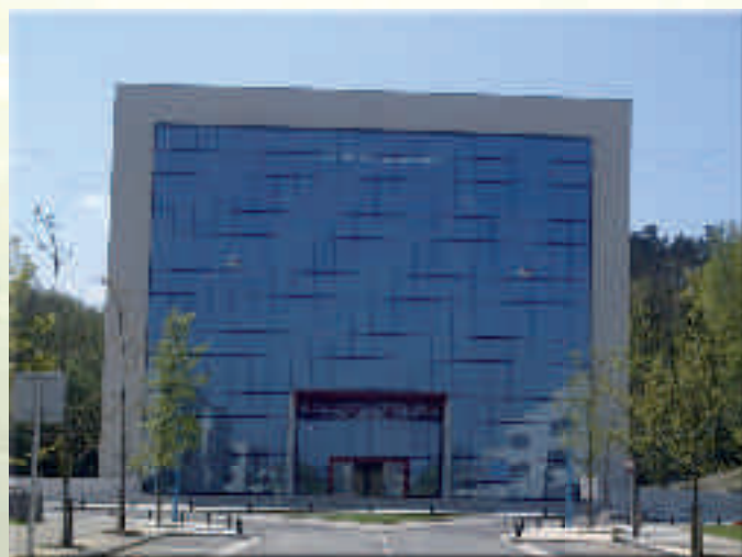
Edificio torre de Zuatzu
